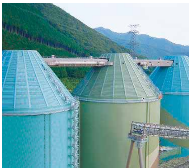
関西電力(株)舞鶴火力発電所サイロ
