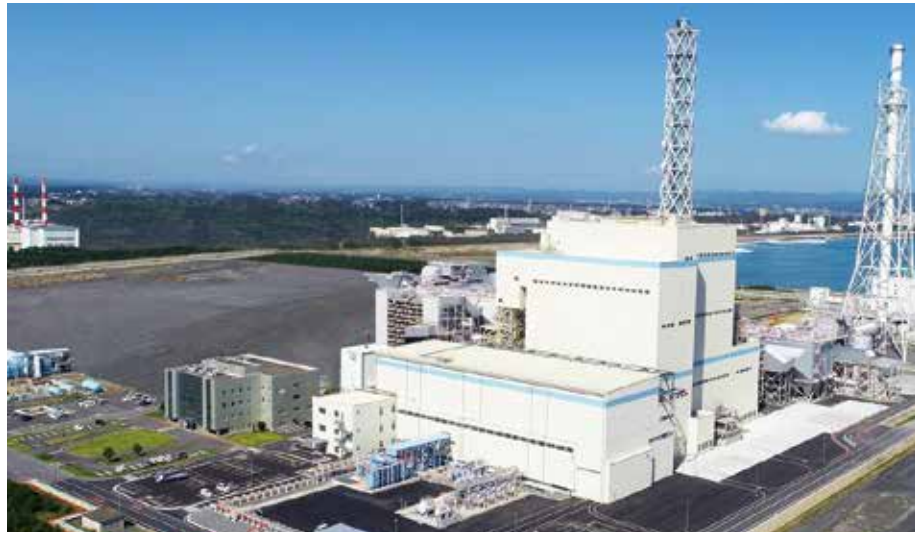
常陸那珂火力発電所
